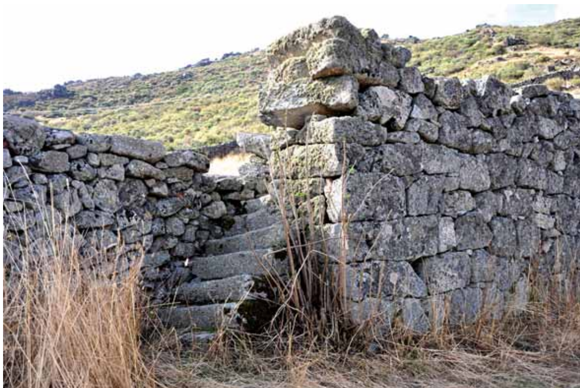
Ermita de las Fuentes (San Juan del Olmo). Escalera externa de acceso a la presidencia.
