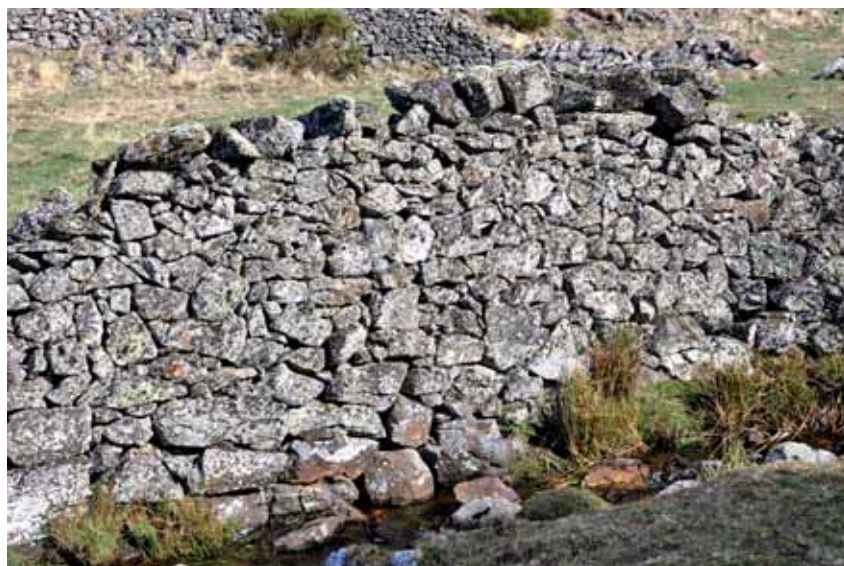
Ermita de la Piedad (San Martín de la Vega del Alberche). Detalle de la mampostería rematada en cobijas.
