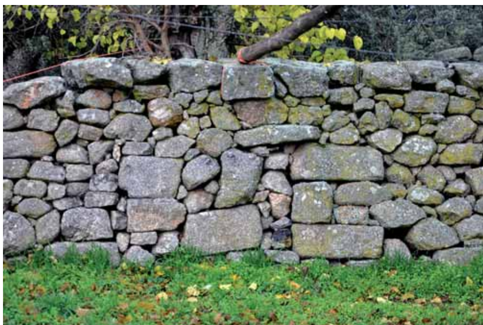
Ermita de Ntra. Sra. del Espino (Gallegos de Sobrinos). Hueco abocinado actualmente cegado.
