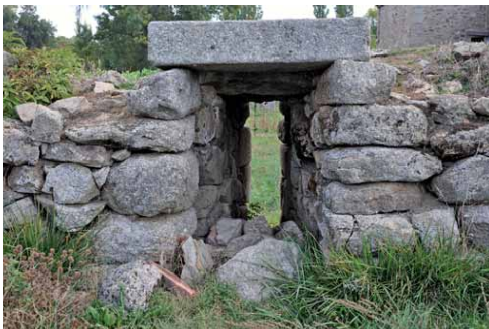
Ermita de la Vega (Piedrahíta). Hueco abocinado visto desde el exterior.
